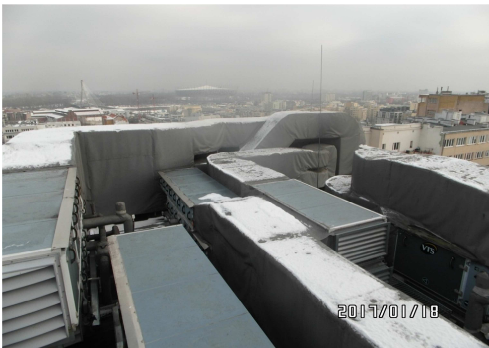
Wentylatory wyciągowe z pomieszczeń sanitarnych
