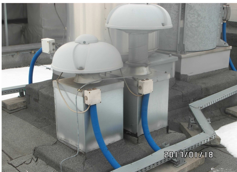
Wentylatory wyciągowe z pomieszczeń sanitarnych
