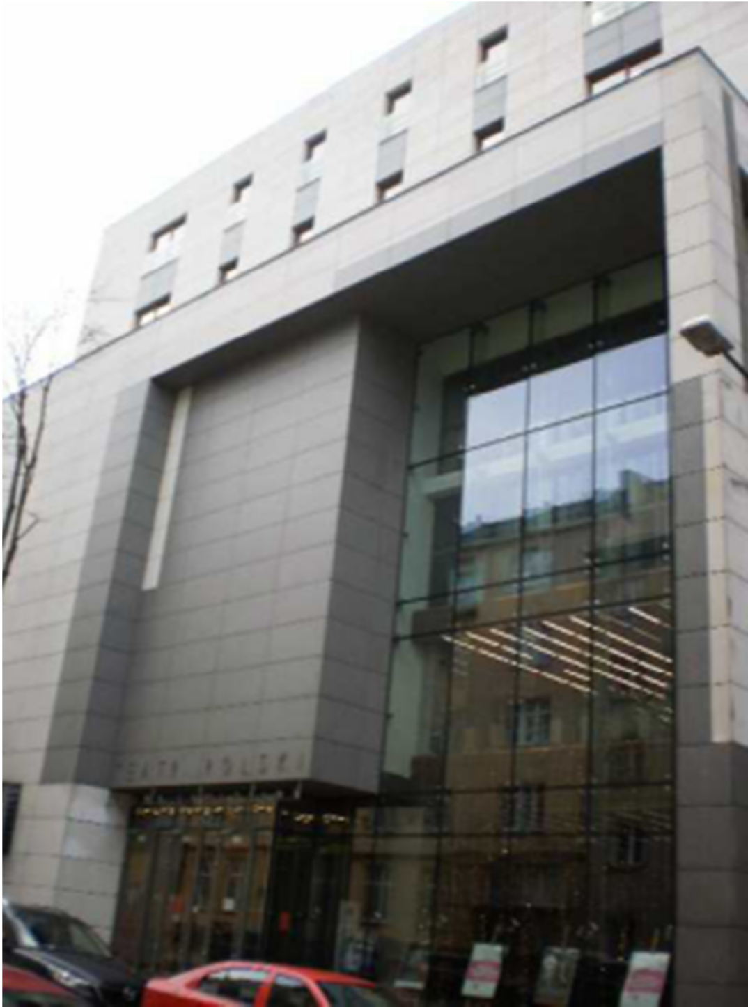
Front budynku { strona wschodnia }
