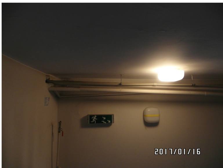
Przewody c.w.u. w piwnicach
